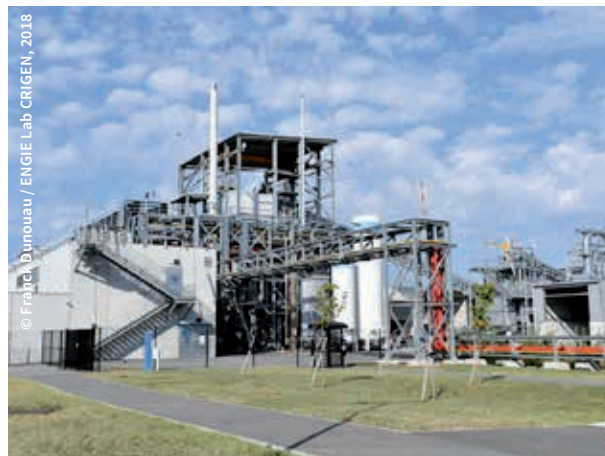
Plateforme du projet Gaya
