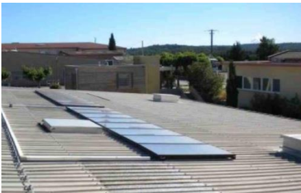
Crédits : Ademe, Les Exemples à suivre, Nettoyage de cuves de production chez Melvita à Lagorce (07)
