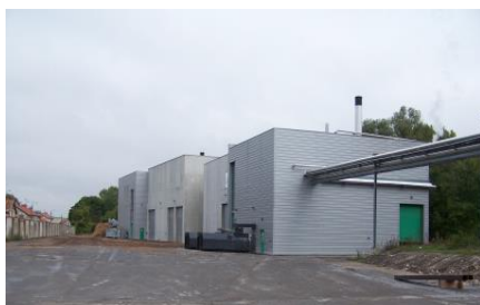
Crédits : Everbal, Chaufferies biomasse sur le site d'Evergnicourt
