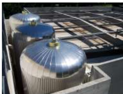
Cuves d'hydrostockage
