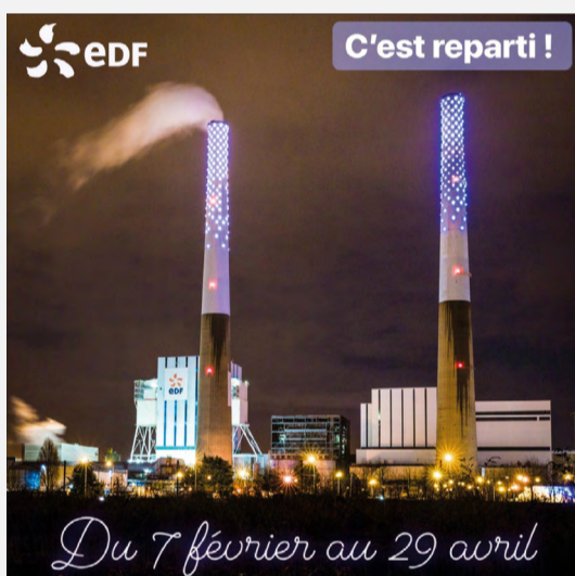
↑ La centrale du Havre s'illumine
