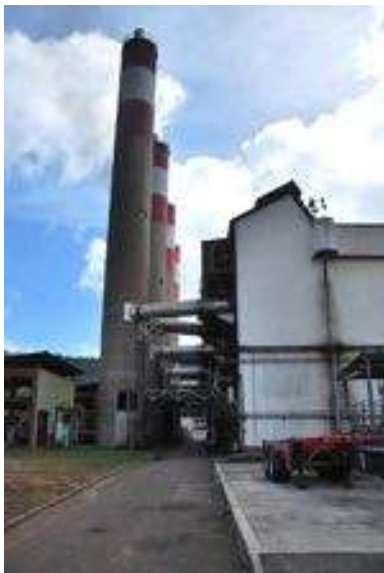
Centrale de Dégrad des Cannes
