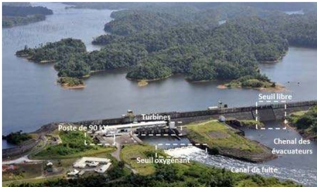
Vue d’ensemble du barrage
