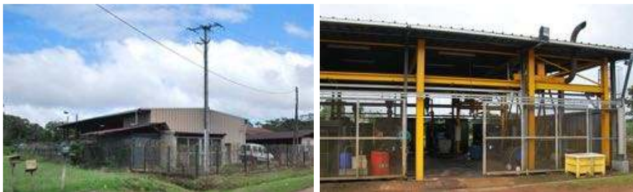
Vue de l'extérieur du bâtiment principal
