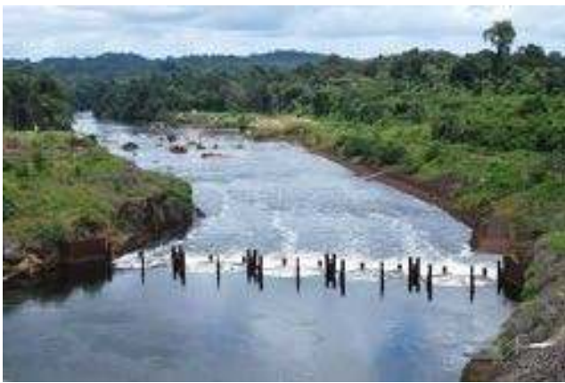
Seuil oxygénant dégazant
