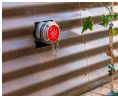
Bouche de remplissage du silo
