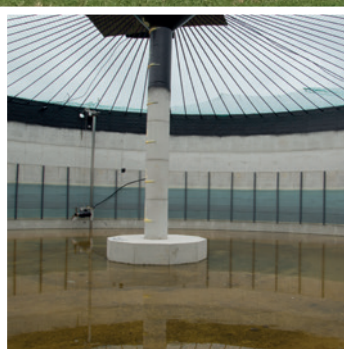
2 Digester diamètre 21 m, hauteur 6 m équipé de mélangeurs, réseau de chauffage à 40°C, désulfuration biologique
