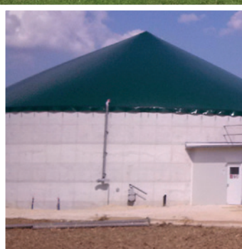
3 Stockage de digestat diamètre 21 m, hauteur 6 m
