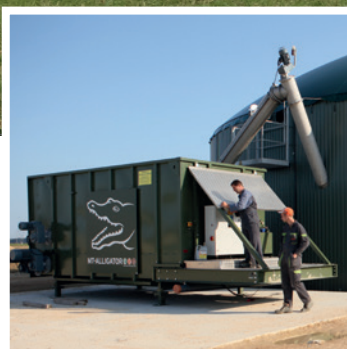
1 Trémie d'alimentation en matières solides Alligator+, 28 m 3
