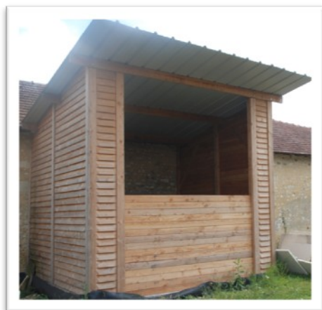
Le silo d'une capacité de 60 m 3 construit intégralement en bois derrière la chaufferie
