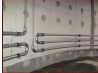
**Une surverse** (tube de 400 mm de diamètre) permet le passage par gravité de la matière du digesteur vers le post-digesteur. Un système d'injection d'air ou d'eau permet le débouchage de celle-ci en cas d'accumulation de matière solide à l'intérieur.
