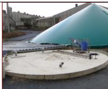
Les volumes de lisiers et de substrats extérieurs présents dans chaque fosse sont **contrôlés en continu par des sondes radar**. Les volumes transférés dans le digesteur sont eux contrôlés par l'automate grâce à des **débitmètres électromagnétiques**. **Un enregistrement automatique** est également réalisé permettant la réalisation automatique de l'historique de l'alimentation du digesteur.
