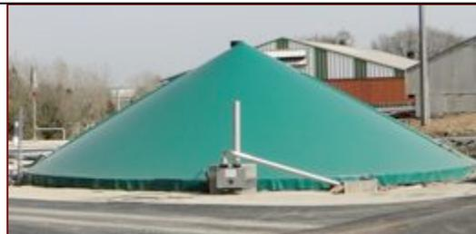
**Le volume de biogaz** pouvant être stocké dans la membrane **est de l'ordre de 340 m<sup>3</sup>**, auquel s'ajoute le volume du post-digesteur non occupé par du digestat, soit au final l'équivalent d'environ 12 heures de production de biogaz.
