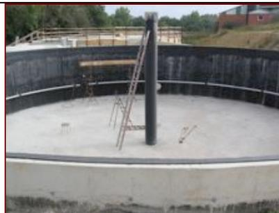
Il est constitué de la fosse à lisier de 730 m<sup>3</sup>, initialement existante sur le site. Cette fosse **a été rehaussée de 40 cm** (pour l'intégration du rail de fixation du gazomètre) et **un poteau central** a été coulé pour permettre la mise en place du gazomètre. Le voile a été également recouvert par **deux couches de résine époxy** afin de protéger le béton des éventuelles attaques acides dû au stockage du biogaz.
