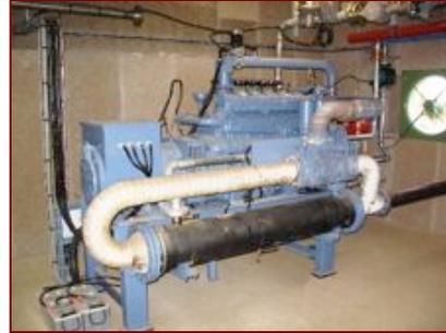
**Deux échangeurs de chaleur sont installés pour récupérer la chaleur produite par le moteur et sur les gaz d'échappement.** L'eau chaude ainsi récupérée est en partie utilisée pour maintenir en température le process de méthanisation.
