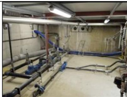
Elle peut ainsi être utilisée pour **réaliser des transferts du digesteur vers le post-digesteur** (en cas de bouchage de la surverse) **ou du post-digesteur vers le digesteur** (dans le cas de la mise en place d'une recirculation du digestat). La canalisation de biogaz traversant cette zone, la gaine est **continuellement ventilée** et équipée **d'une centrale de détection de CH<sub>4</sub> et CO<sub>2</sub>**, afin d'éviter la formation d'une atmosphère toxique ou potentiellement explosive.
