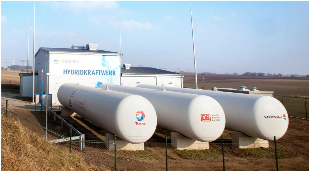
*Réservoirs d'hydrogène et bâtiment qui abrite l'électrolyseur*
