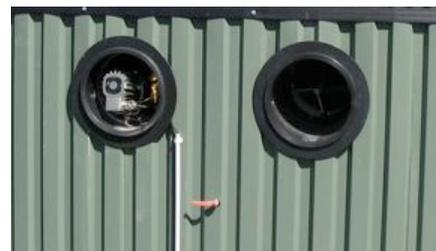
Des hublots de visualisation placés sur le haut du fermenteur, au-dessus de la surface de la matière en fermentation permettent de visualiser l'intérieur du fermenteur et surveiller la production de biogaz ainsi que d'éventuelles apparitions de couches ou de mousse en surface.
