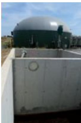
Le lisier de veaux est incorporé via une canalisation et une pompe directement dans le fermenteur, à intervalles réguliers.
