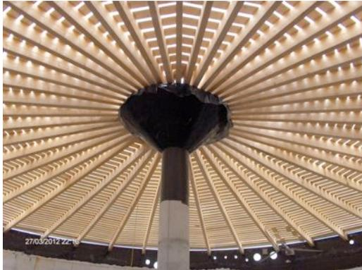
Avant d'être stocké dans le collecteur double membrane, le biogaz passe à travers une **chambre de désulfuration**. Il s'agit d'une structure en bois située entre le haut du fermenteur et le collecteur double membrane. Une faible quantité d'oxygène est injectée au niveau de cette structure bois afin de favoriser l'oxydation du soufre contenu dans le biogaz ; cette oxydation est assurée par des bactéries présentes sur le plancher en bois. Le soufre se cristallise pour retomber dans le digestat.
