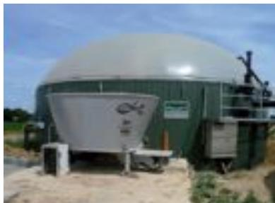
A l'aide d'un tracteur équipé d'un godet, Gildas FOUCHET remplit quotidiennement de substrats solides une **trémie de 8 m<sup>3</sup>** équipée d'un système de pesée et placée sur une dalle béton, à proximité immédiate du fermenteur.
