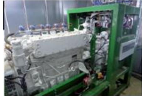
Le co-générateur installé consomme environ 53,2 m<sup>3</sup> de biogaz par heure avec les caractéristiques suivantes :
