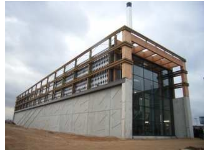
Chaufferie de Planoise à Besançon
