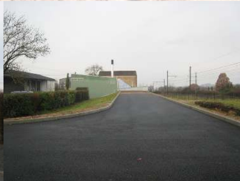
Rampe d'accès au silo
