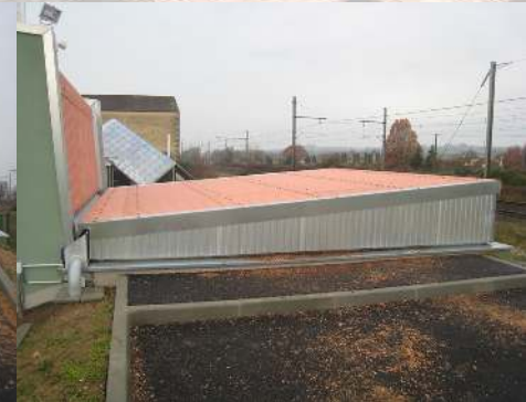
Couverture amovible du silo
