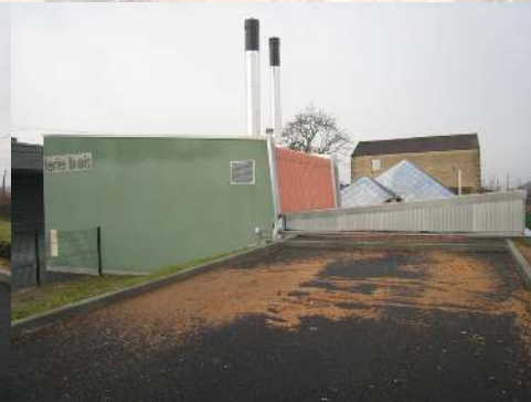
Zone de livraison de combustible
