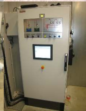
GTC Gestion technique centralisée
