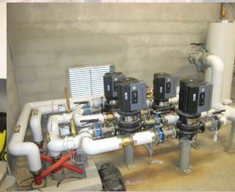
Pompes à débit variable
