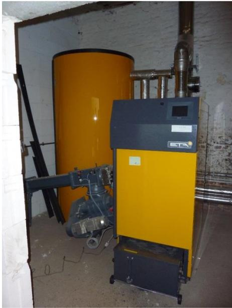
Figure 8- La chaudière, le ballon tampon et la vis d'alimentation sur la gauche
