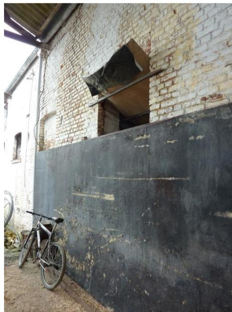
Figure 11- La trémie d'alimentation du silo
