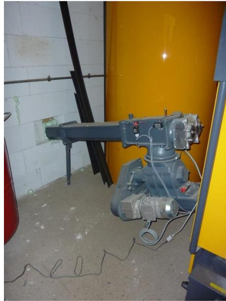
Figure 9- La vis d'alimentation en gros plan
