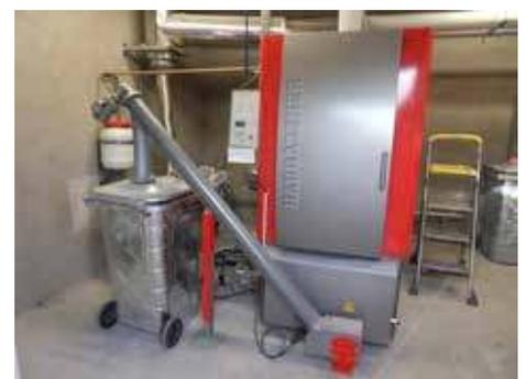
Chaudière de 200 kW avec cendrier déporté de grande capacité
