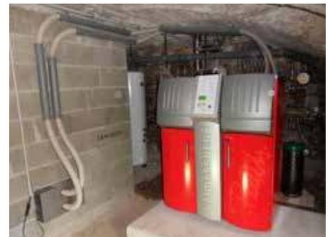
Chaudière de 16 kW avec commutation automatique double RAPS
