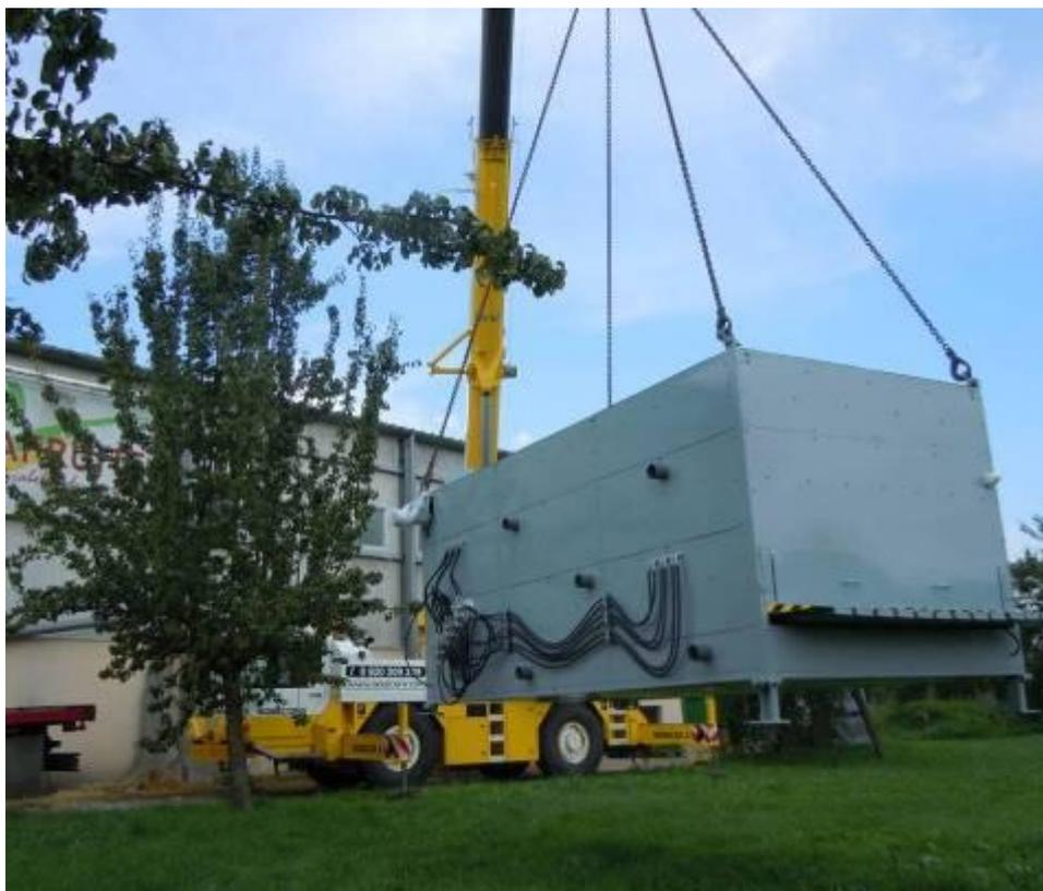
9 août 2013 : Installation du sécheur chez le client
