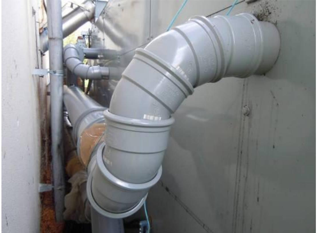
19/9/2013 : Arrivée de l'air chaud (du ventilateur) aux trois niveaux d'étage du sécheur
