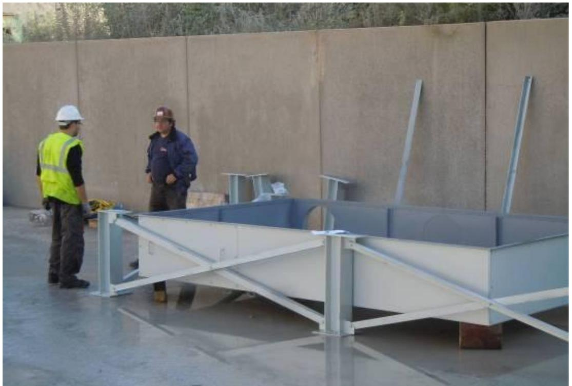
Mise en place du caisson de ventilation au dessous du fond mouvant à tôle perforée
