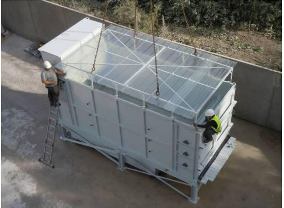
Mise en place du toit transparent (pour profiter également de la radiation solaire)
