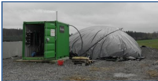
Figure 2 : Unité de biométhanisation de 10 kWé à la ferme Devos (Framont).
