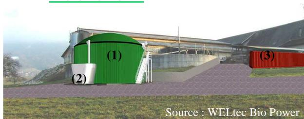
L'unité sera mise en service durant l'été 2009 et sera constituée d'un digesteur en acier (1), avec chauffage et agitateur, d'une trémie d'alimentation (2), d'un module de cogénération (3), d'un séparateur de phases, de deux cuves à digestat et d'une plateforme de stockage des intrants.
