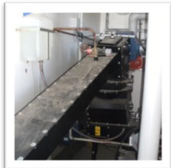
Le bois est convoyé dans le silo grâce à un fond mouvant puis un tapis (photo ci-dessus) achemine les plaquettes jusqu'à la chaudière
