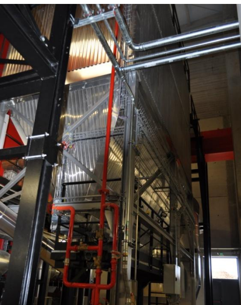
>> Une des deux chaudières biomasse de 8 MW thermique
