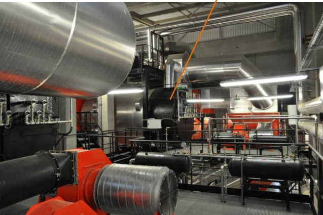
>> Une des deux chaudières biomasse de 8 MW thermique
