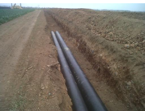
>> Réseau de chaleur eau chaude reliant la chaufferie biomasse à la chaufferie centrale d'Evreux-La Madeleine
