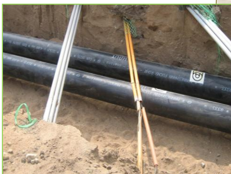
Réseau de chaleur
