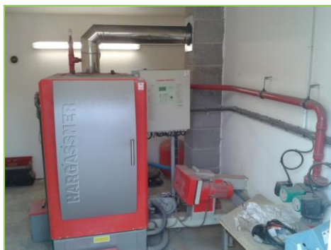
Chaufferie : chaudière Hargassner 100 kW
