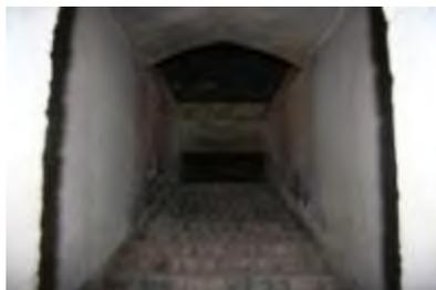
Figure 15 : Briques réfractaires de la chambre de combustion (foyer à grilles mobiles)
