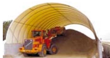
Surélévation de la structure sur des murets.
