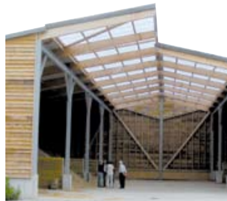
Ci-dessus un exemple avec une entrée de lumière par le centre de la charpente.
