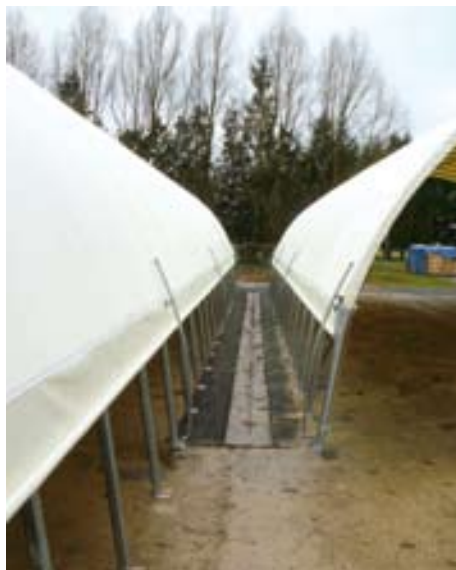
Surélévation de la structure sur des murets.
