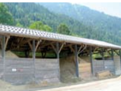
2 exemples de bâtiments existants revalorisés pour stocker des plaquettes forestières et de scieries.
