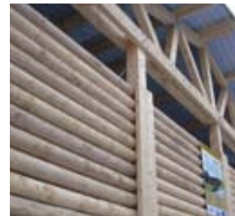
Parois en rondins usinés.
