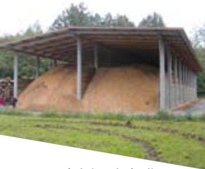
Hangar bois énergie de Bières en Suisse.
