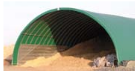
Mise en place de tôles de soubassement pour protéger la structure.
