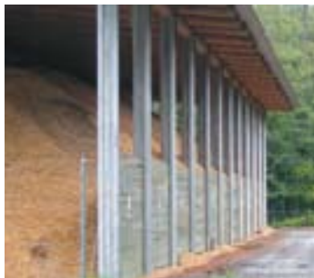
Parois en bastaings empilés.
