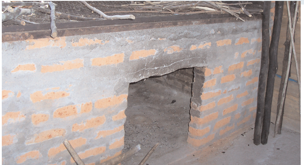
Four traditionnel avec des soucis d'efficacité énergétique et de fumées nocives
