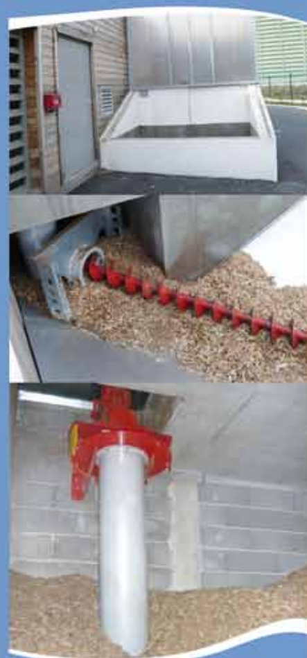
Trémie de déchargement avec vis verticale de remplissage du silo
